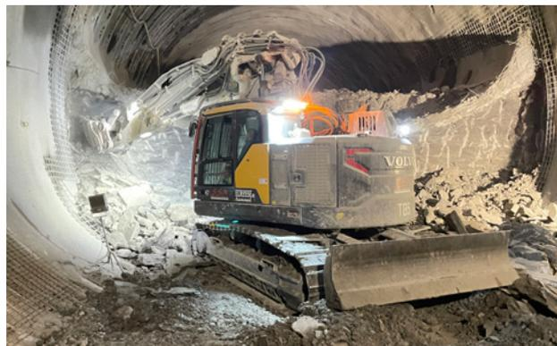
Volvo Kompakt-Tunnelbagger ECR355-T mit Reißlöffel beim Grabvortrieb von einem doppelgleisigen S-Bahntunnel
