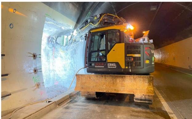
Volvo Kompakt-Tunnelbagger ECR145-T mit 65 kW-Fräse beim Erstellen von Versorgungsnischen in einem Autobahntunnel
